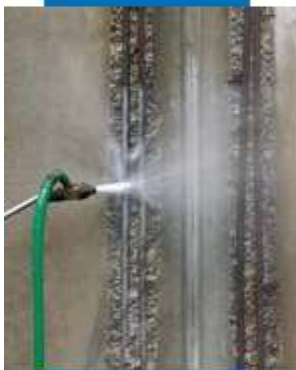
Armatūros strypų valymas
