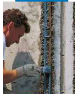
Mapefer tepimas ant armatūros
