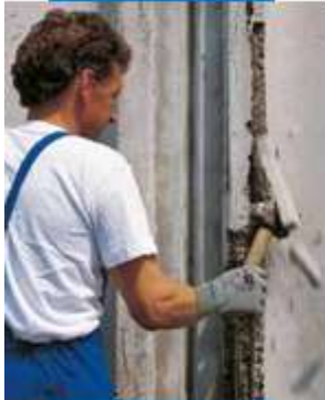
Silpno betono galinimas
